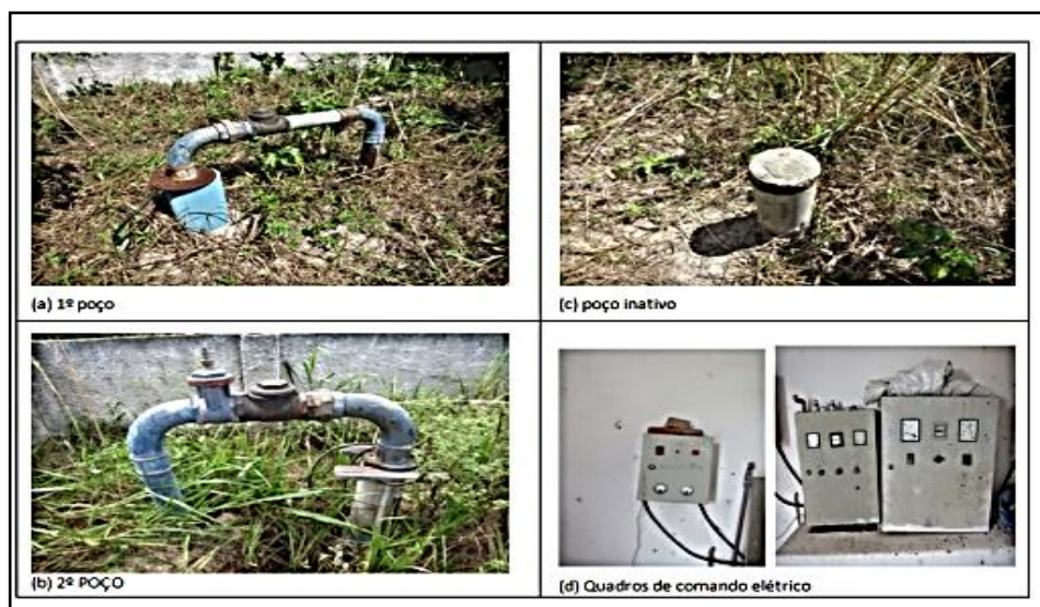
Figura 3.1.6 – Pontos de captação do sistema de abastecimento de água da sede do Município de Vera Cruz.
