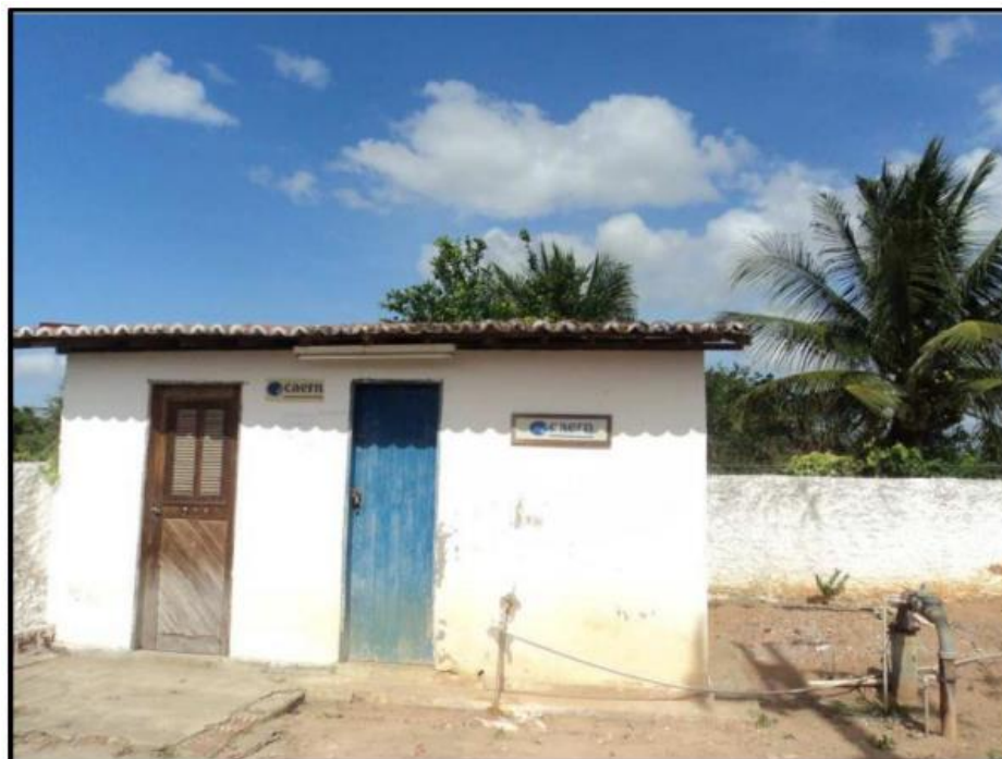
Figura 3.1.16 – Vista geral da área de localização do poço que integra o SAA de Cobé.
