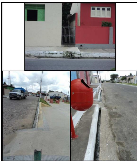
Figura 3.2.1 – Lançamento de águas cinza no sistema de drenagem pluvial.
