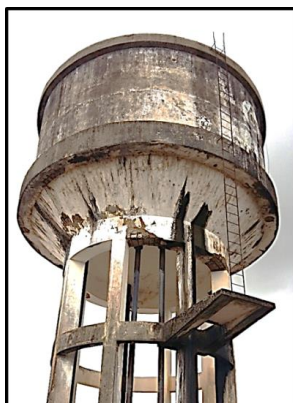
Figura 3.1.9 – Escada de acesso do reservatório elevado da sede do Município de Vera Cruz.
