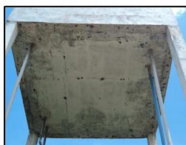
(b) Fissuras/infiltrações
