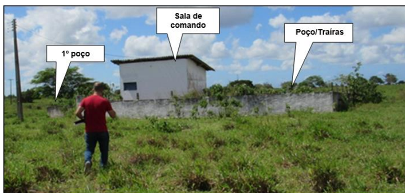
Figura 3.1.4 - Vista da área de localização do primeiro poço que integra o SAA da sede do Município de Vera Cruz. (Latitude: 6° 1' 57,10'' S/Longitude: 35° 25' 4,63''O)
