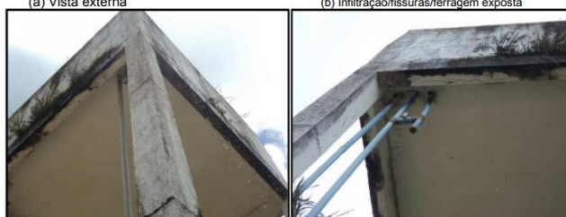
(c) Infiltrações/fissuras
