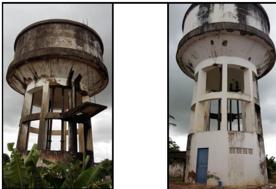
Figura 3.1.7 – Reservatório elevado da sede do Município de Vera Cruz.
