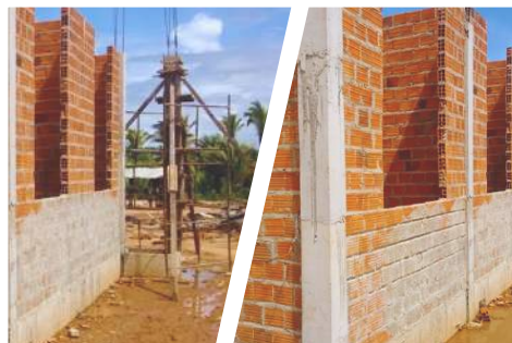
Figura 12- Arquivo Canva - Sistema convencional de Obra
