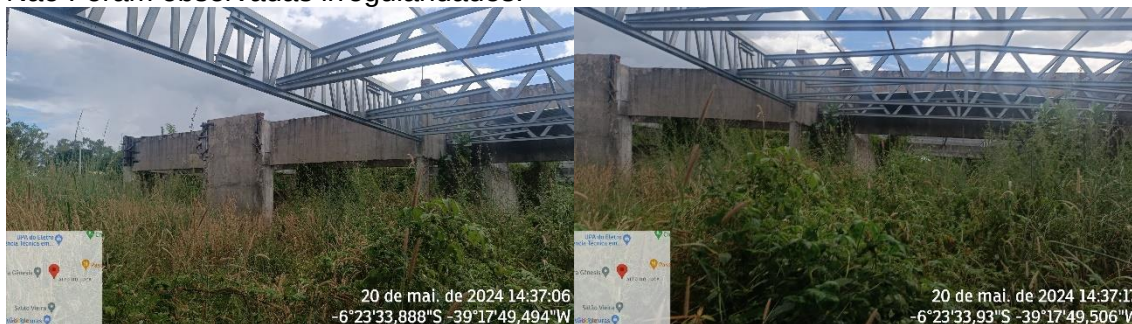
Figura 23 e 24 – Estrutura da coberta para patio. Fonte: elaboração própria.
