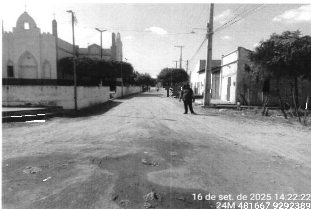
Foto 2 – Final na E4+9,05
