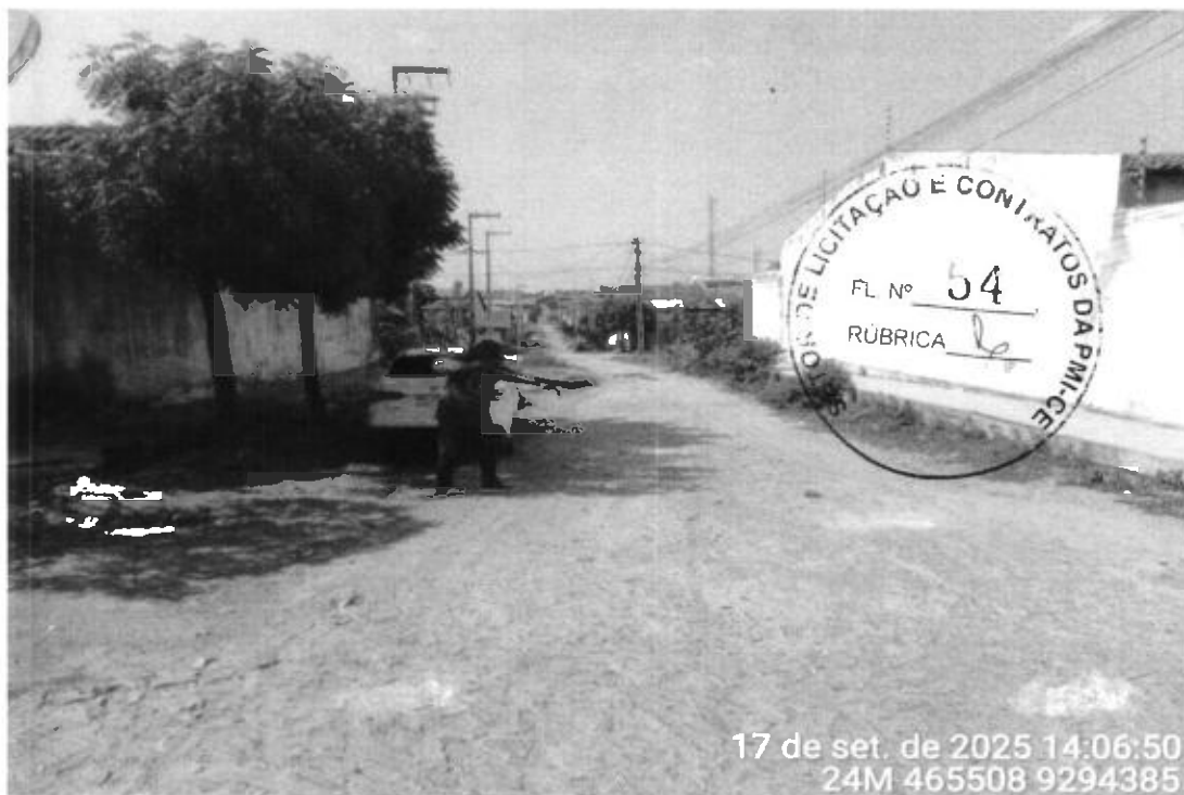
Foto 1 – Início na Rua Ademar Gomes Pereira (Antiga Rua 22/C)
