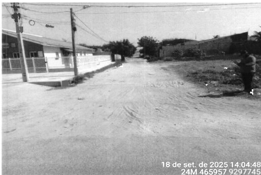
Foto 2 – Final na Av. Alberico Cavalcante Mendonça (Antiga Av. dos Cajueiros)
