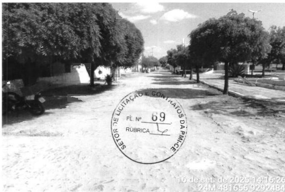
Foto 1 – Início na Rua Francisco Holanda Montenegro
