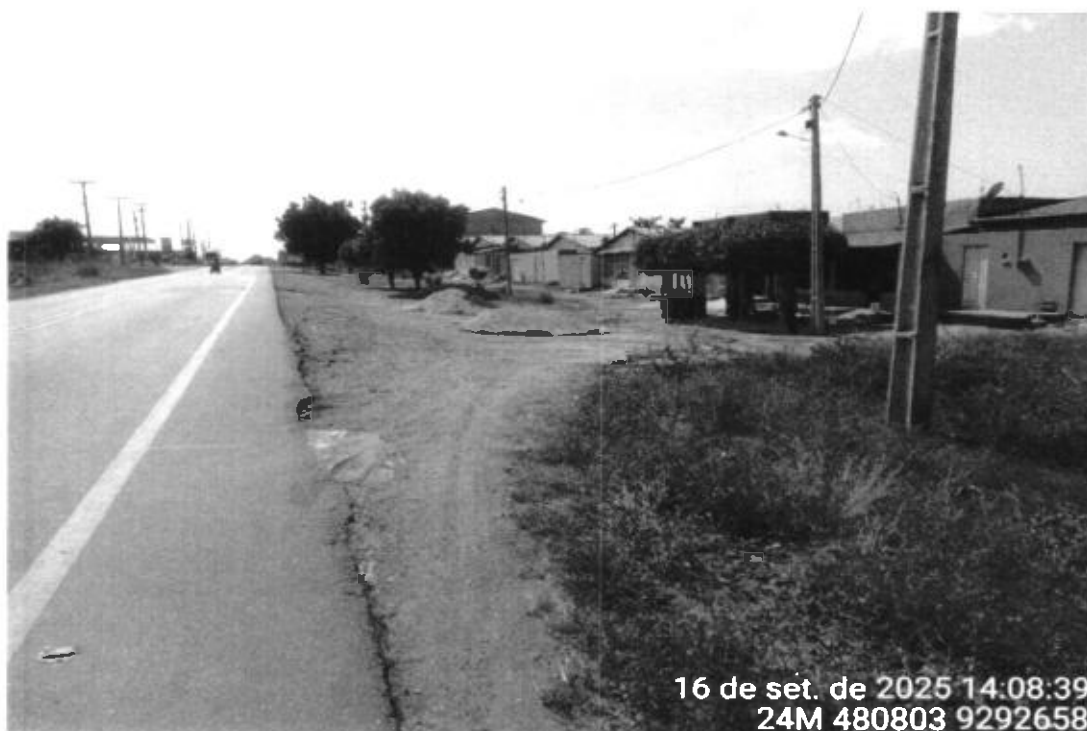
Foto 2 – Final na Rodovia Estadual CE-282
