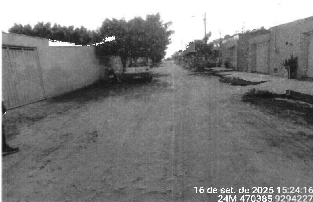
Foto 2 – Final na E12+13,90
