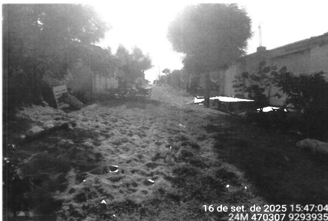
Foto 2 – Final na E7+0,10
