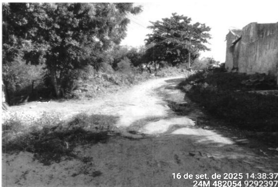
Foto 2 – Final na Rua 09 do Loteamento Esplendor
