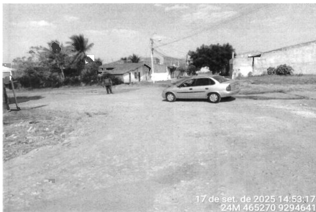
Foto 2 – Final na Rua Irmã Rita de Cássia (Antiga Rua Projetada 08)
