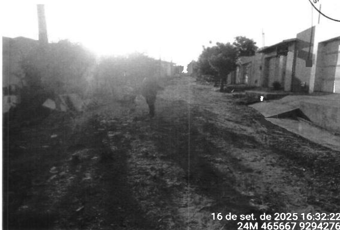
Foto 2 – Final na E4+12,75
