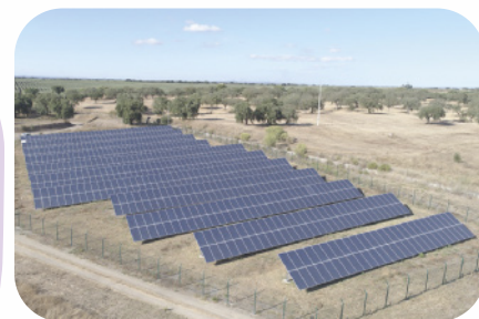
● Placas de captação de energia solar, no município do Rio de Janeiro, capital do estado, em 2020.
