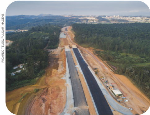
● Construção de rodovia em Guarulhos, São Paulo, em 2018.
