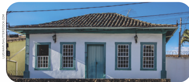
● CASA DE ALVENARIA EM SANTA LUZIA, MINAS GERAIS, EM 2020.
