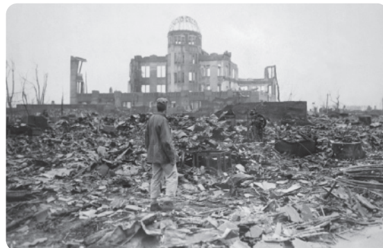
Ruínas do Museu da Ciência e Indústria, destruído pela bomba atômica. Hiroshima, Japão, 1947.
