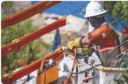
▲ Eletricista realizando manutenção da rede elétrica no município de São Paulo, estado de São Paulo, 2021.
