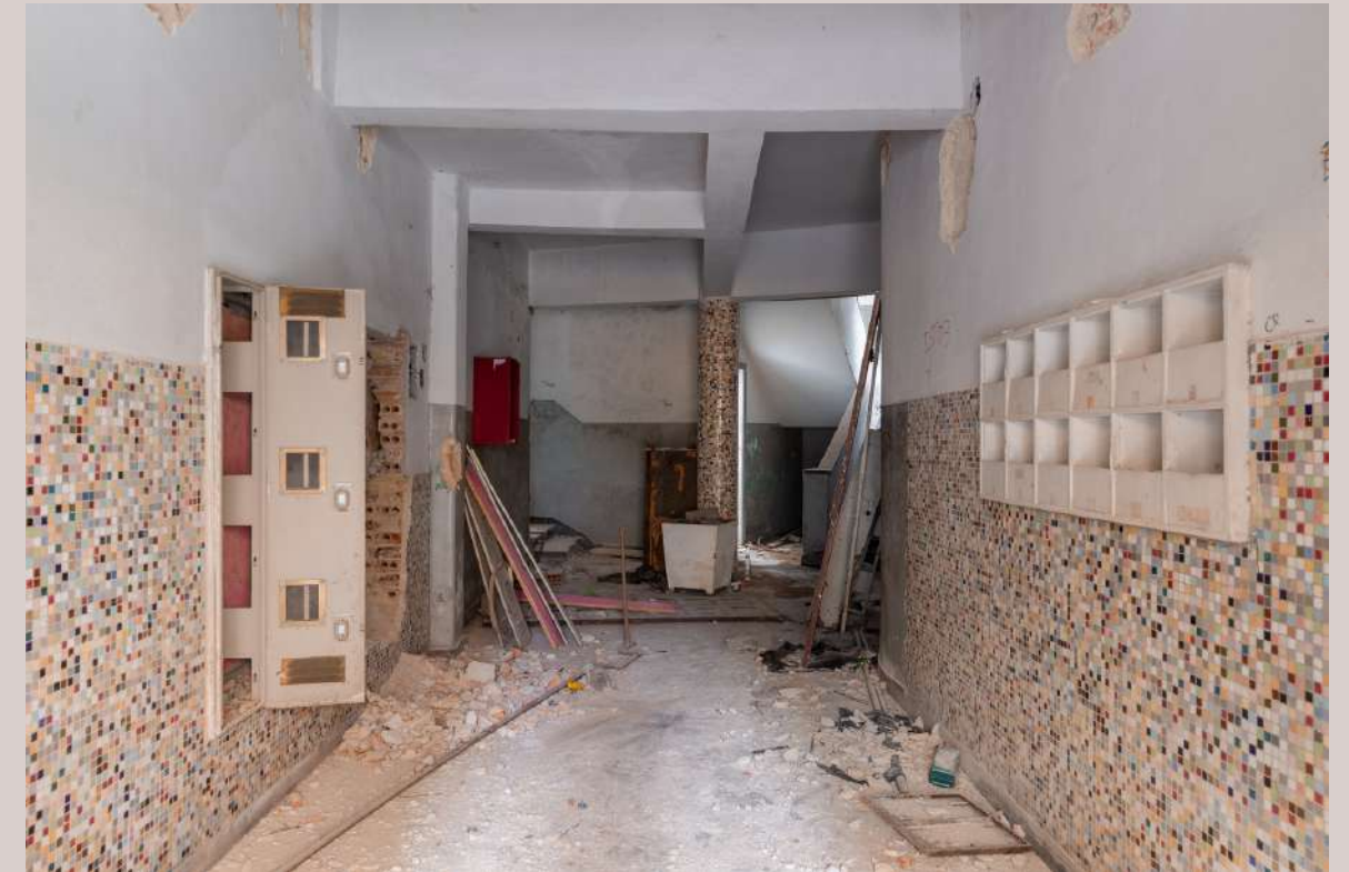
Hall do Edifício Brasil, 2026
