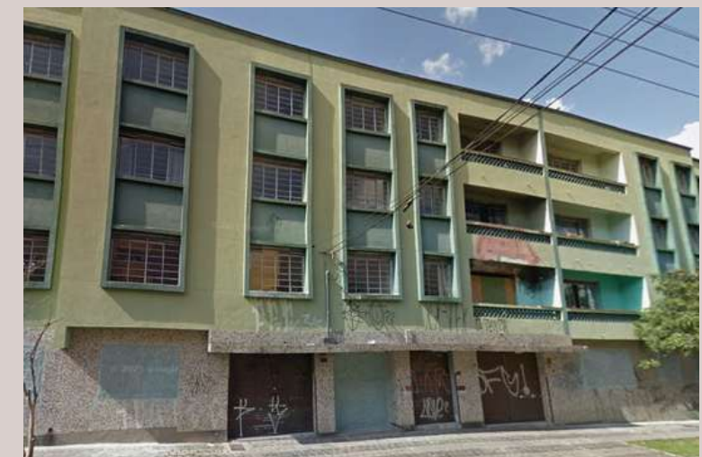
Edifício Brasil, 2014 Google Street View
