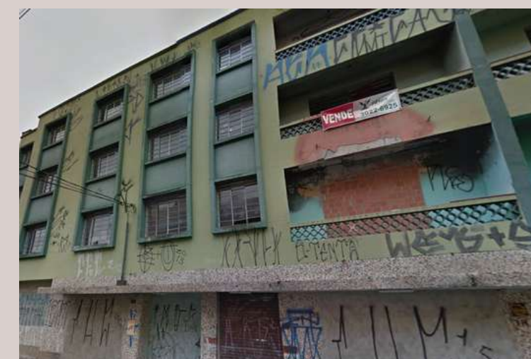
Edifício Brasil, 2017 Google Street View
