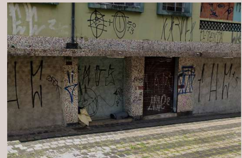
Edifício Brasil, 2019 Google Street View
