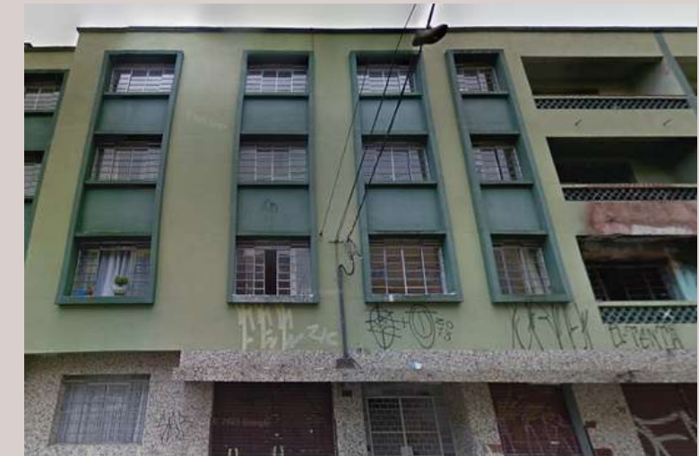
Edifício Brasil, 2013 Google Street View
