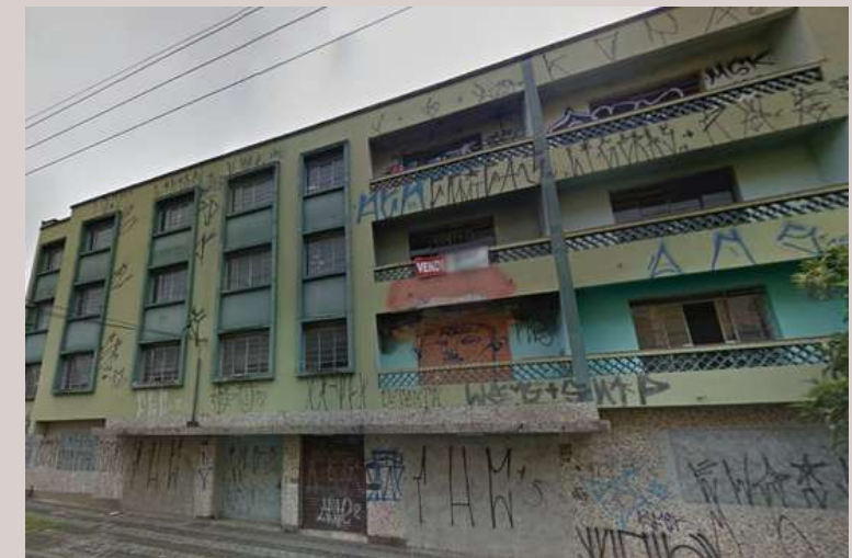
Edifício Brasil, 2018 Google Street View
