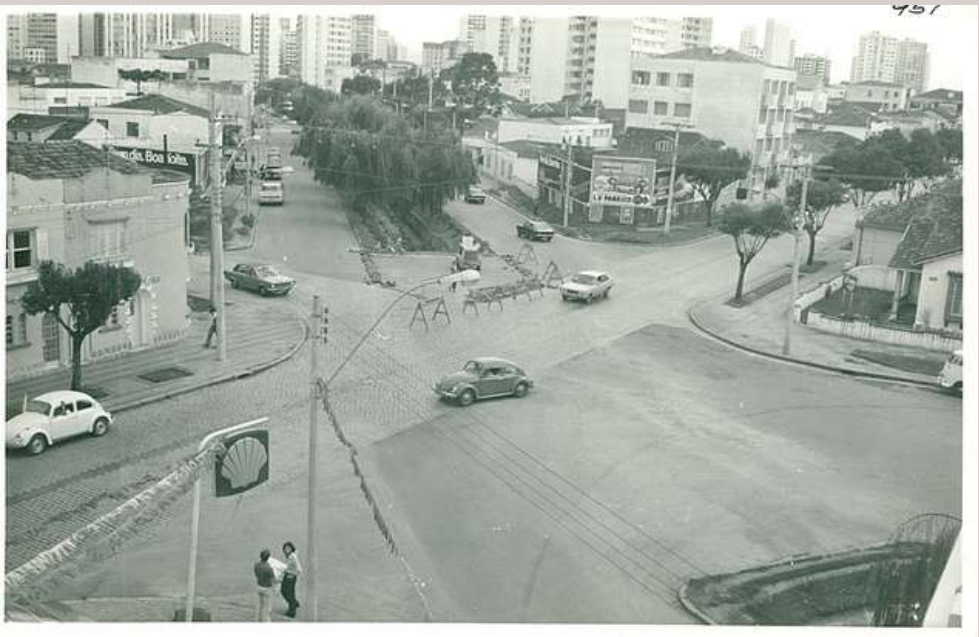
Obra na Rua Professor Fernando Moreira, 1976
