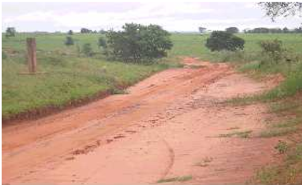
Figura 11 - Rodovia internacional ao longo da divisa do Brasil com o Paraguai, no município de Japorã, MS, onde um marco de divisa pode ser observado à esquerda.
