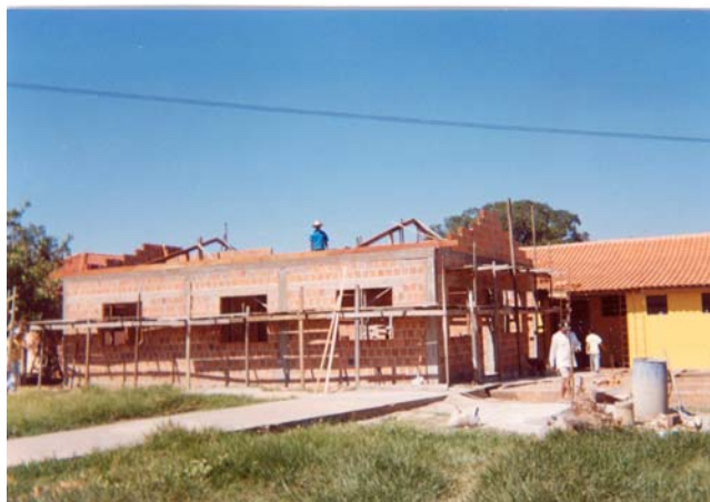
Figura 8. Vista da ampliação física do Núcleo Escolar Santana, município de Aquidauna, Mato Grosso do Sul, agosto/2003.
