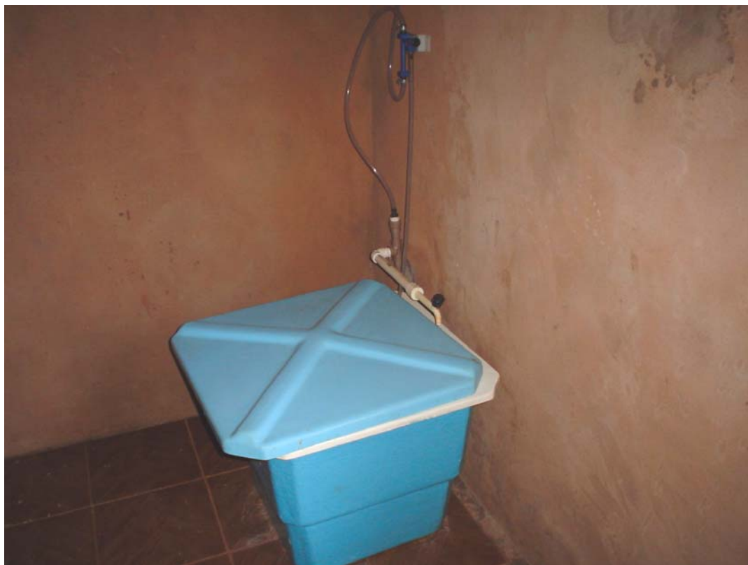
FOTO 5 – UNIDADE DE TRATAMENTO DE ÁGUA UTILIZADA NA PRODUÇÃO.
