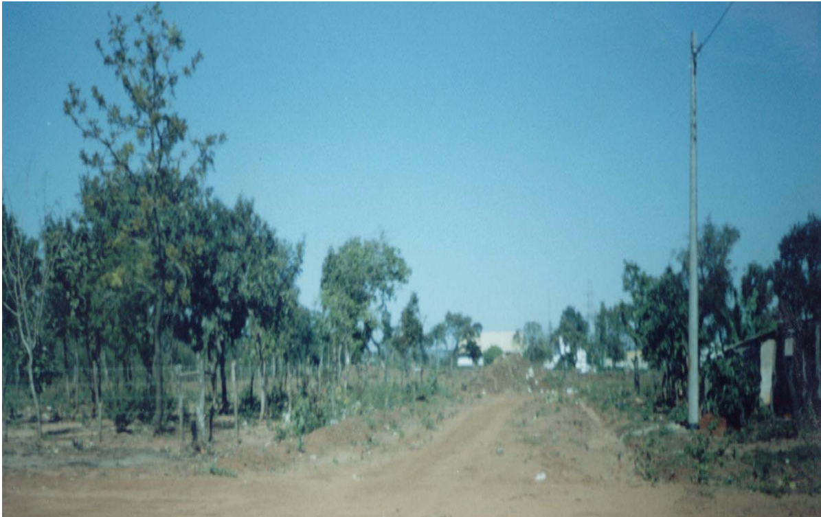
Figura 7 . Obras do arruamento do bairro Jardim Noroeste.
