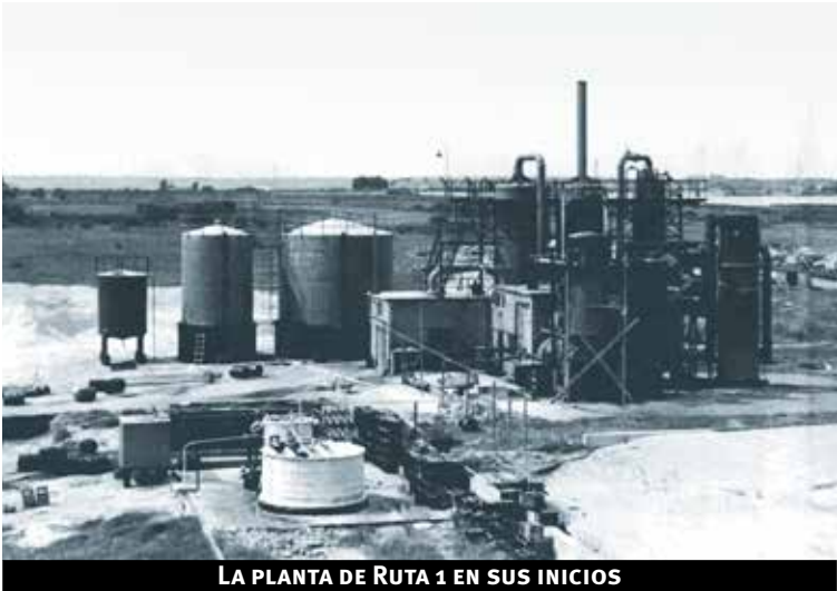
LA PLANTA DE RUTA 1 EN SUS INICIOS
