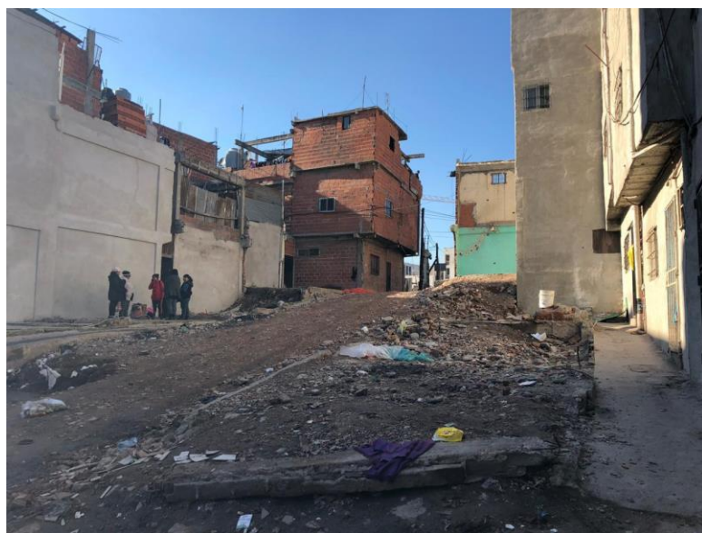
Figura 42. Apertura de la calle Miralla en proceso (julio de 2019)
