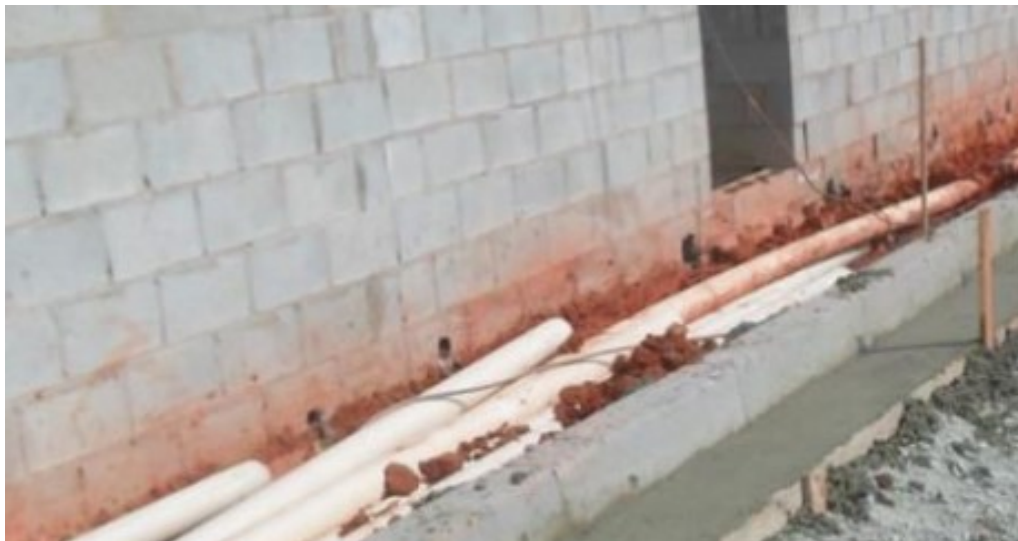
FIGURA 4: Exemplo de execução de sarjeta moldada in-loco
