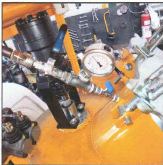
Foto 1 – Detalhe da execução do teste hidrostático.
