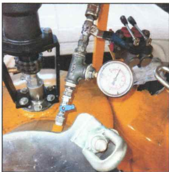
Foto 1 – Detalhe da execução do teste hidrostático.
