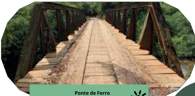
Ponte de Ferro
