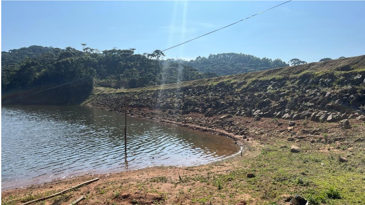
Foto 1. Vista geral do talude de montante a partir da ombreira direita.
