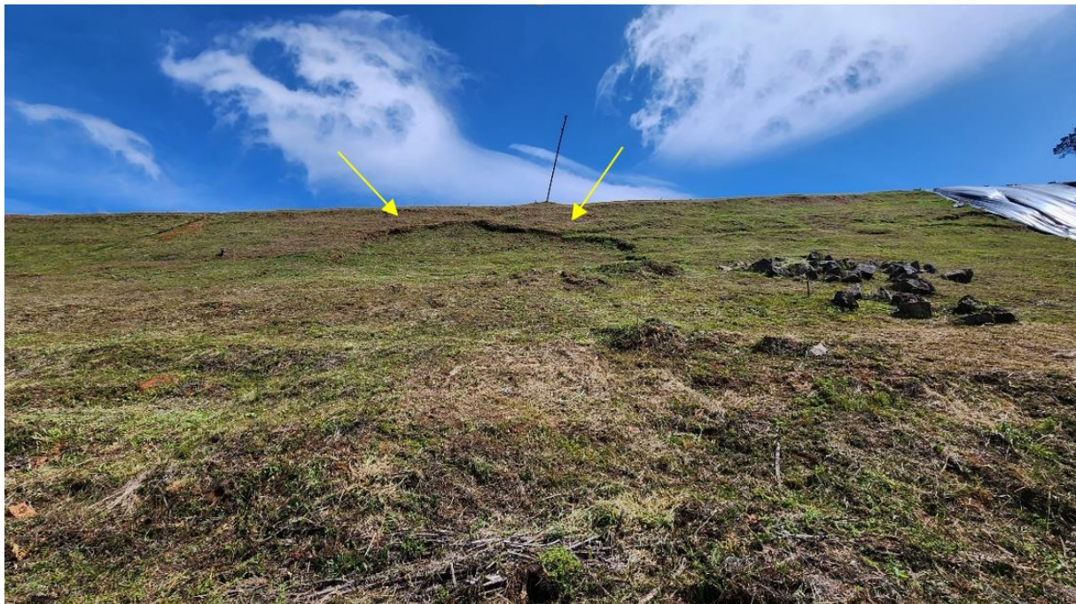
Foto 12. Escorregamento na porção central do talude de jusante.
