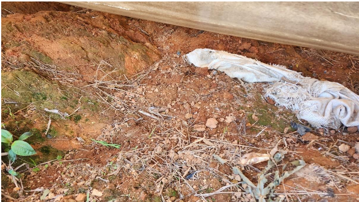
Foto 14. Região do escorregamento embaixo da lona, sem ocorrência de surgências.
