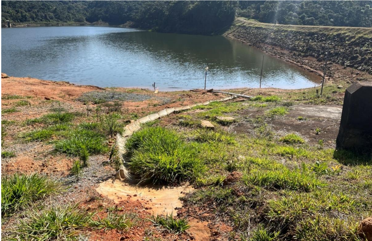
Foto 23. Ombreira direita – Drenagem no encontro com o talude de montante
