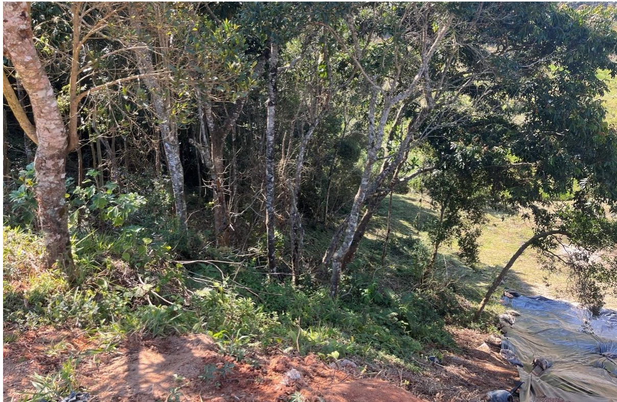
Foto 20. Ombreira esquerda - Encontro com o talude de jusante.
