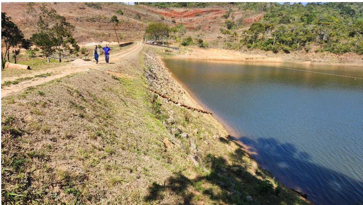
Foto 2. Talude geral do talude de montante a partir da ombreira esquerda.
