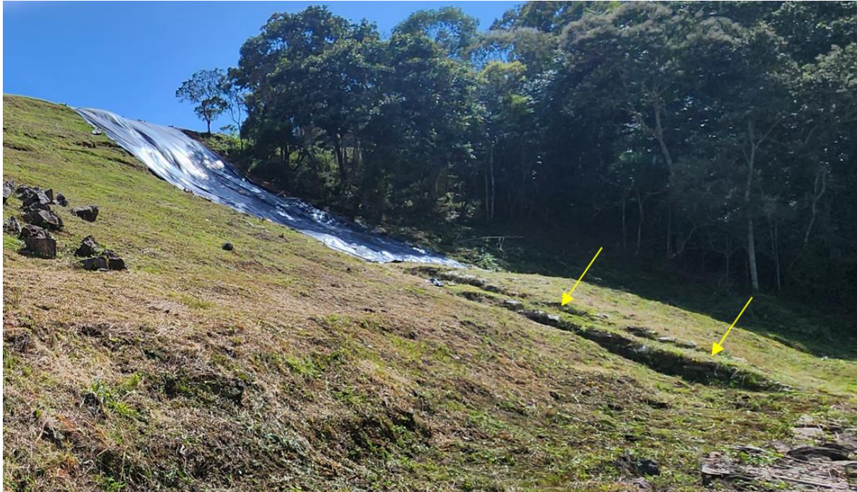
Foto 13. Escorregamento próximo a ombreira esquerda, protegido com solo ensacado e lona. Destaque para os sacos de areia já integrados ao meio.
