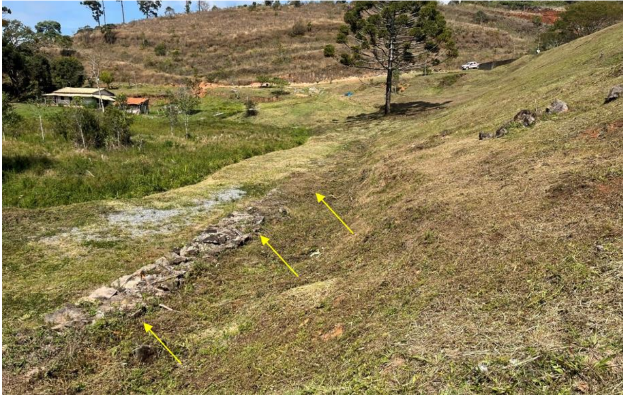
Foto 15. Local onde existe um muro de pedra arrumada (vista a partir da crista da barragem).
