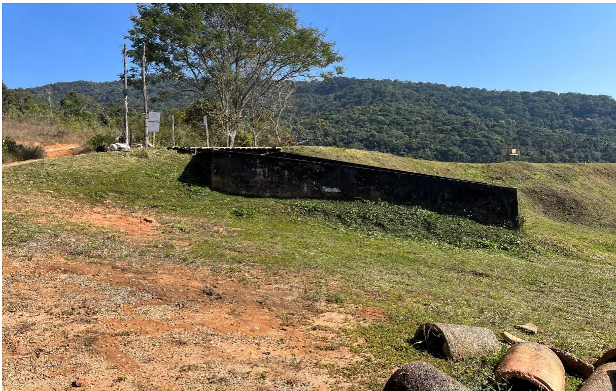
Foto 38. Vista lateral da saída do vertedor.
