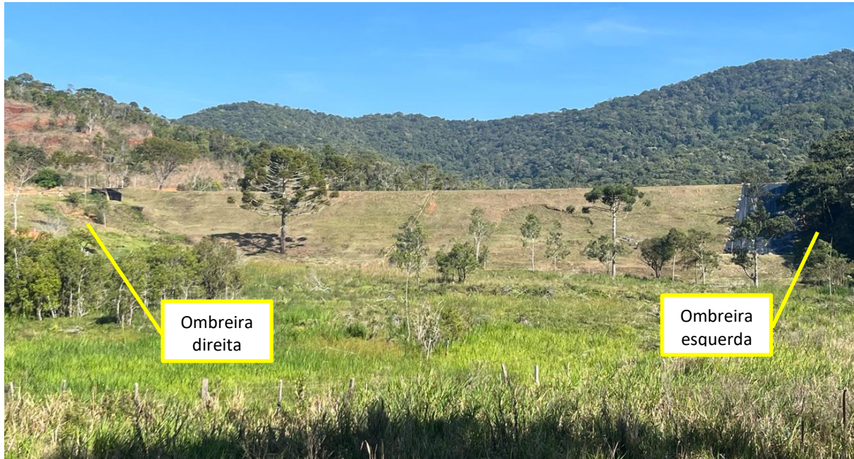
Foto 10. Vista frontal do talude de jusante.
