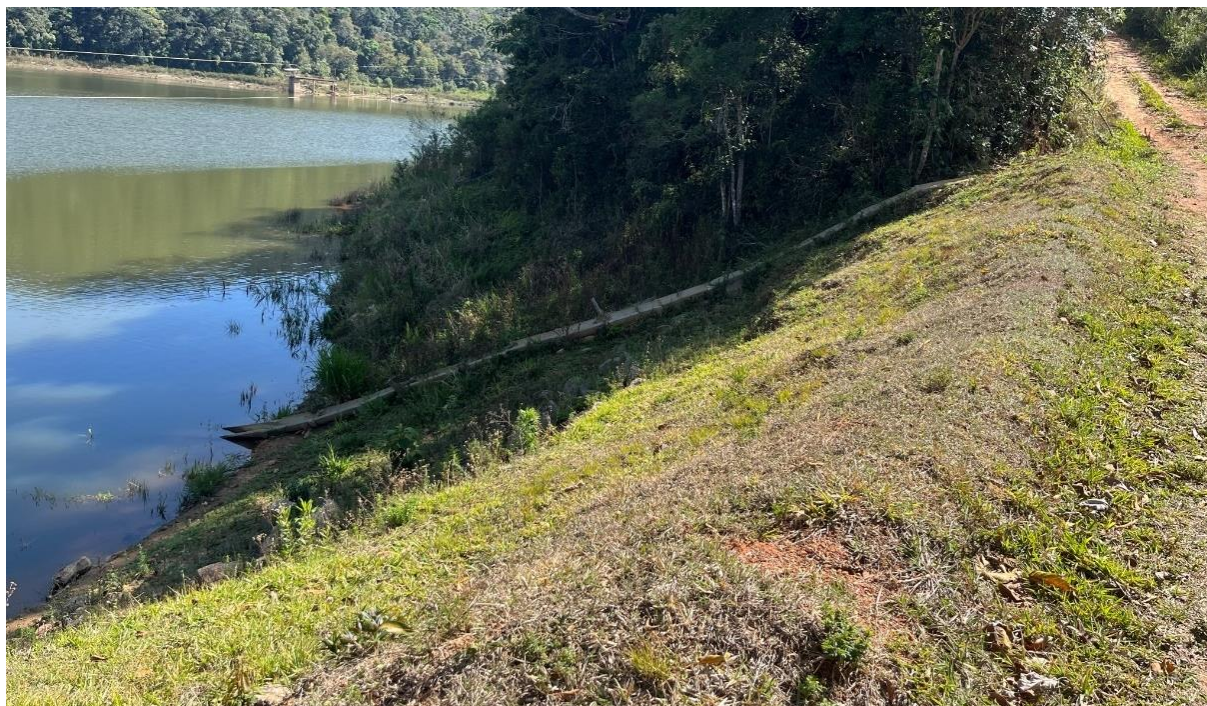
Foto 19. Ombreira esquerda - Encontro com o talude de montante
