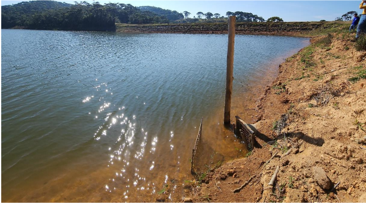
Foto 32. Entrada d'água no vertedor auxiliar.
