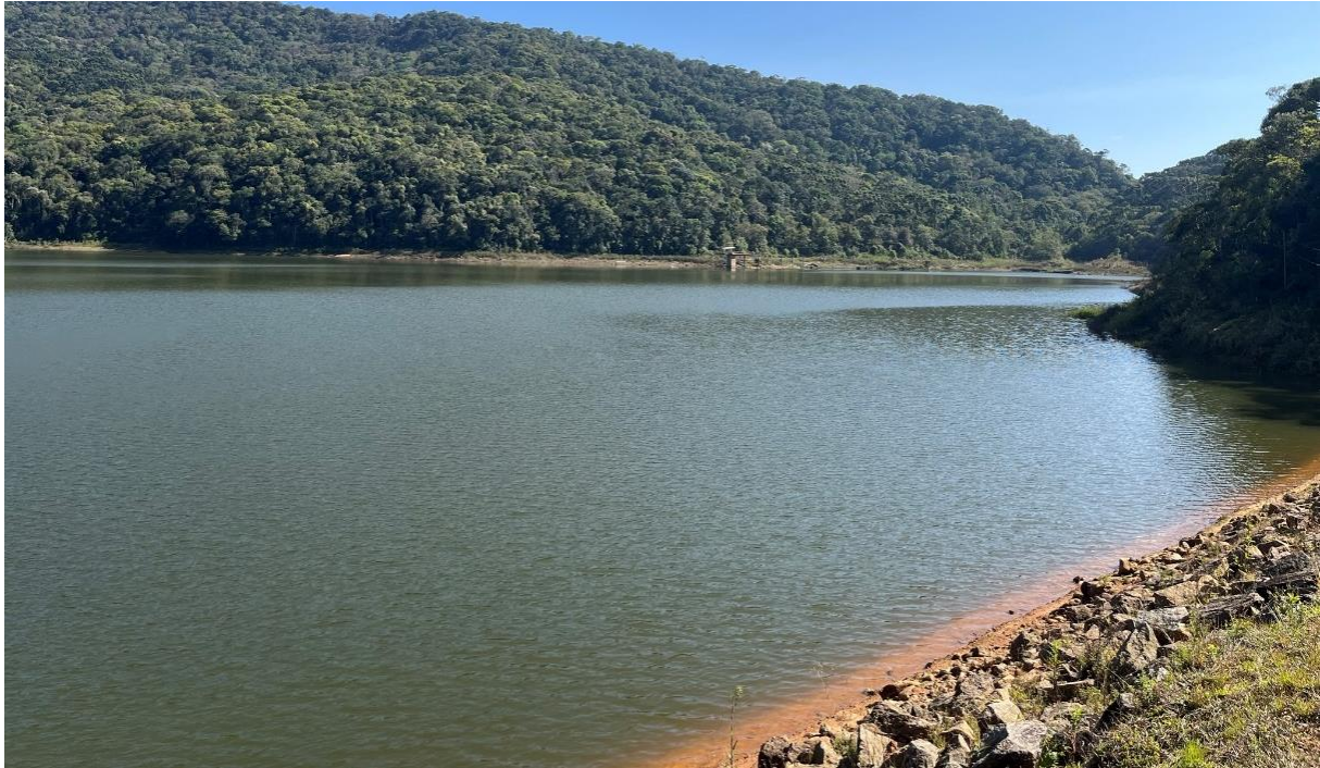
Foto 42. Vista geral para o reservatório da Barragem Brejo Grande.
