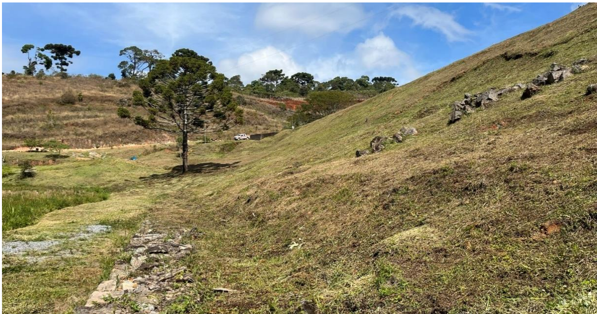
Foto 9. Talude de jusante. Vista para a ombreira direita.
