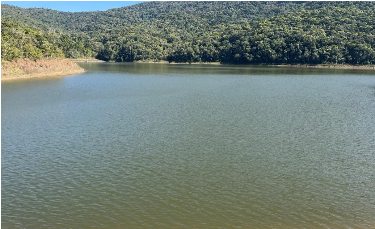
Foto 43. Vista geral para o reservatório da Barragem Brejo Grande.
