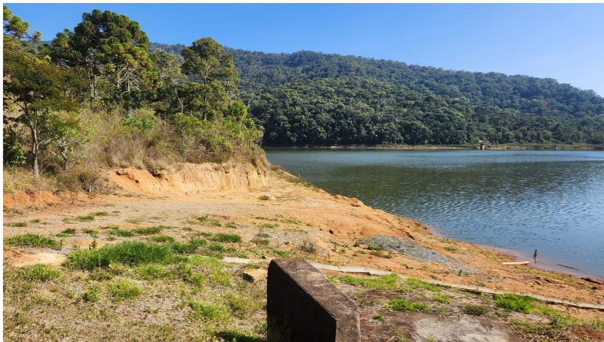
Foto 21. Ombreira direita - Encontro com o talude de montante.
