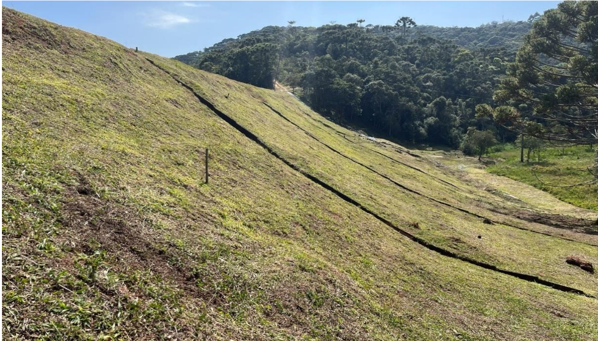
Foto 8. Talude de jusante. Vista para a ombreira esquerda.
