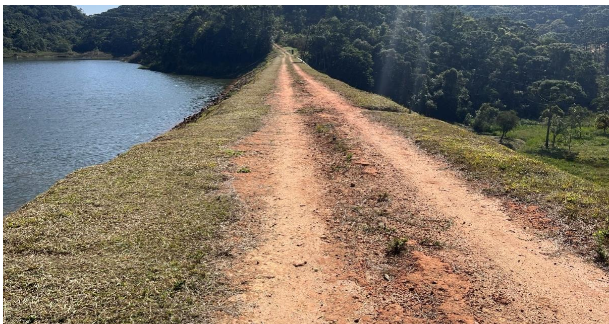
Foto 6. Crista da barragem, vista a partir do centro para a ombreira direita.
