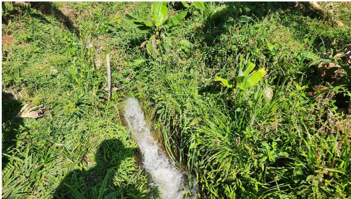
Foto 34. Ponto de deságue do vertedor auxiliar.
