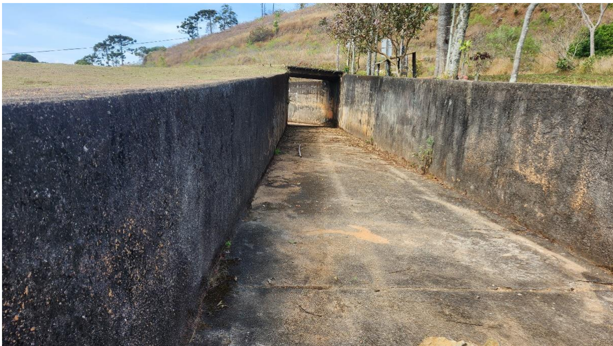
Foto 36. Vertedor – canal a montante.
