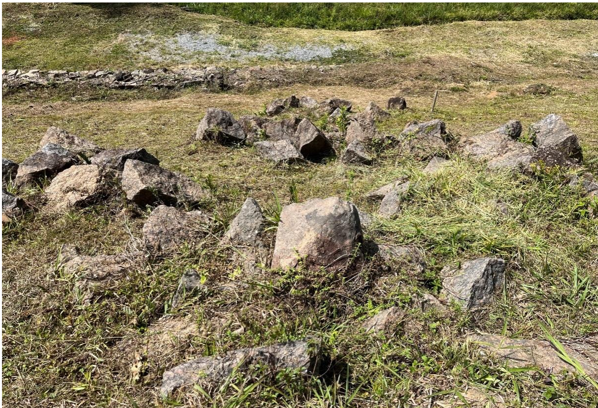
Foto 16. Pedras lançadas sobre o talude de jusante.
