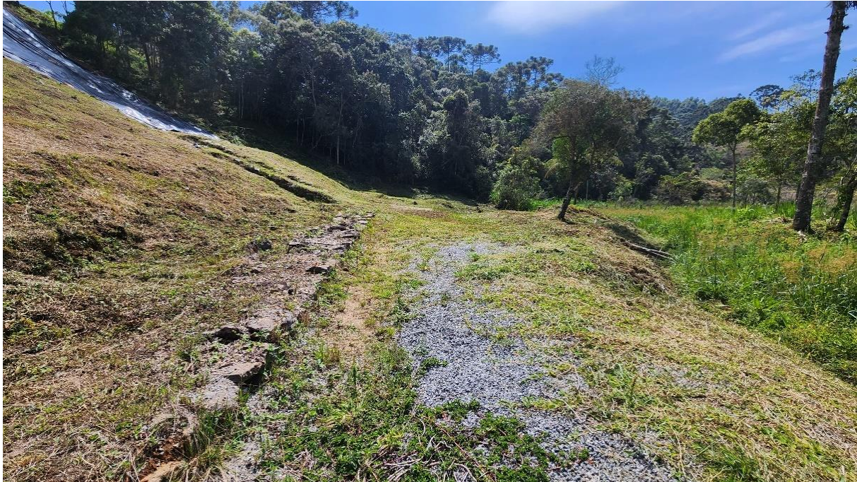
Foto 27. Filtro executado na área de jusante da barragem, já parcialmente recoberto por vegetação gramínea.
