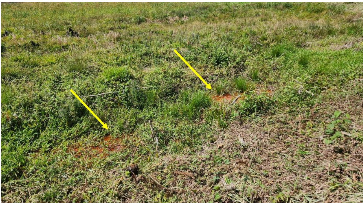
Foto 28. Exarco a frente do filtro, próximo a ombreira direita.
