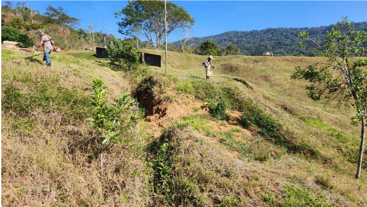
Foto 22. Ombreira direita - Encontro com o talude de jusante.
