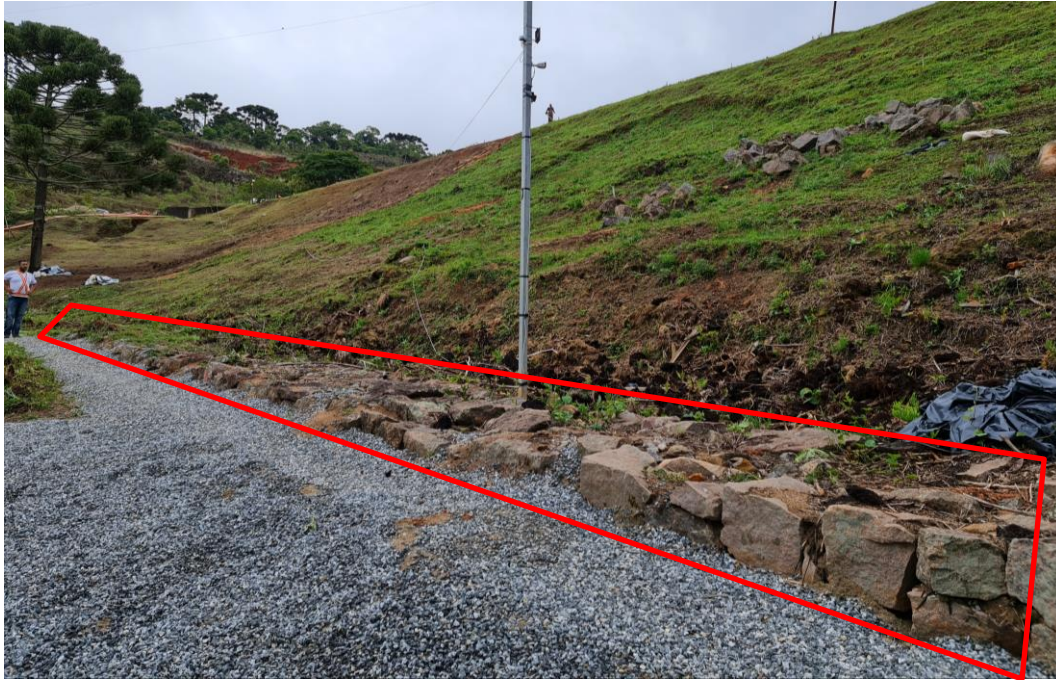
Figura 7. Muro de pedra arrumada a ser demolido.
