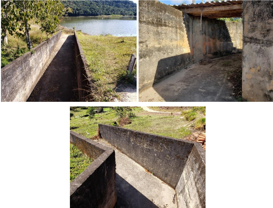
Figura 5. Sistema extravasor a ser demolido.
