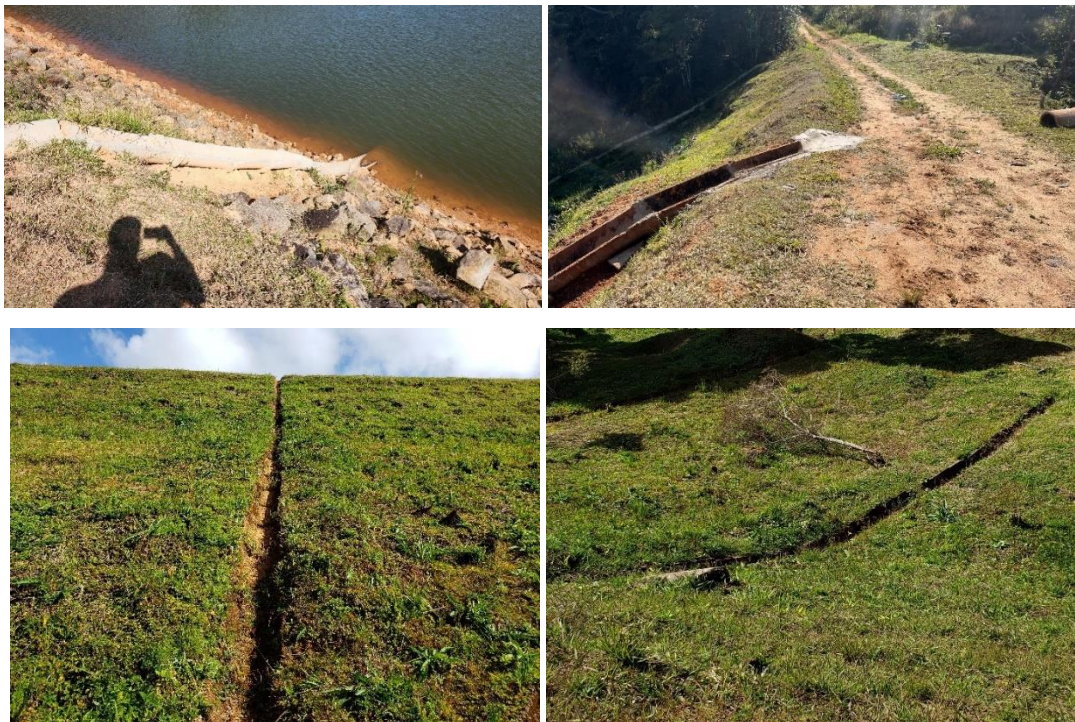
Figura 6. Dispositivos de drenagem a serem demolidos.
