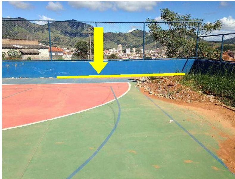
Foto 3 – Inclinação do piso no sentido do limite com o muro indicando a movimentação horizontal e inclinação vertical do mesmo.
