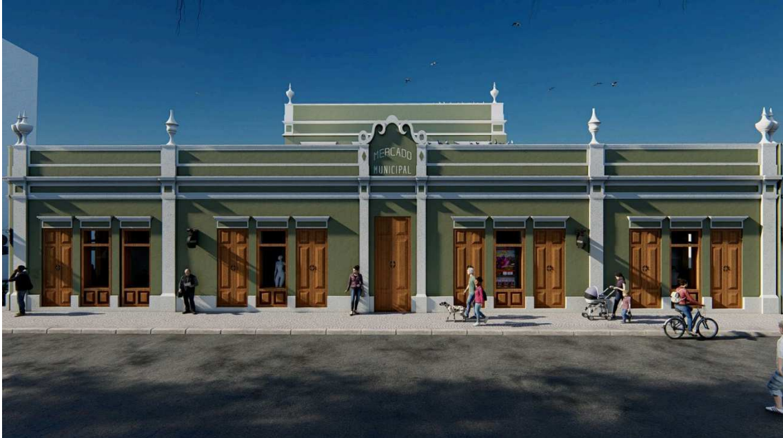
Figura 01: Fachada do mercado municipal
