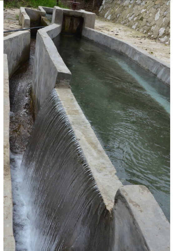
La foto de la izquierda muestra a la directora de Visión Mundial República Dominicana, Carolyn Rose-Avila, visitando la casa máquinas de la micro-hidroeléctrica. En la imagen de la derecha, el canal que conduce el agua a la casa de máquinas.
