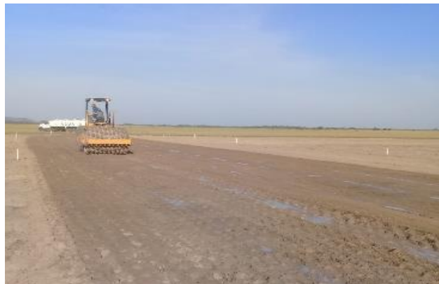
Início da Terraplanagem no site
