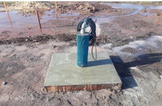
Perfuração do primeiro Poço Artesiano para análise da Água
