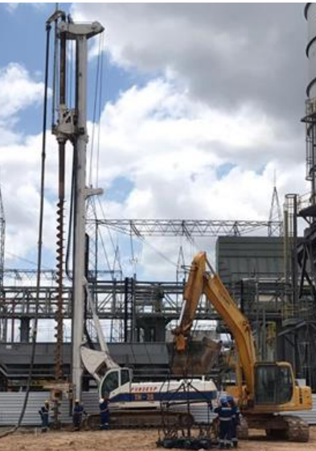
Execução das estacas hélices
