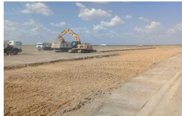
Início da Terraplanagem no site
