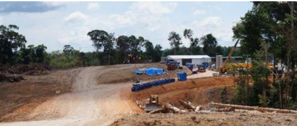
Acesso ao poço
