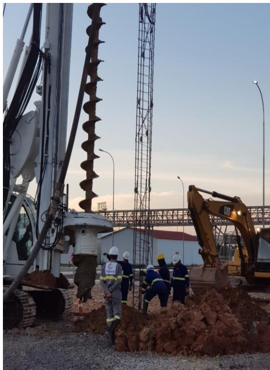
Execução de estaca da Caldeira 32
