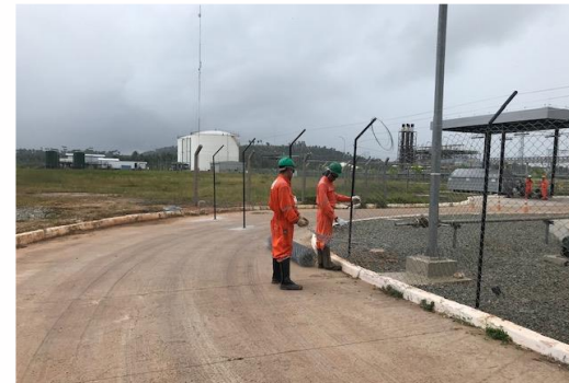
Instalação de cercas na área da PTA
