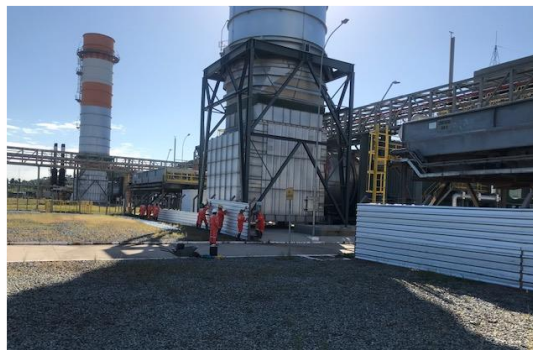
Instalação de tapumes na área operacional
