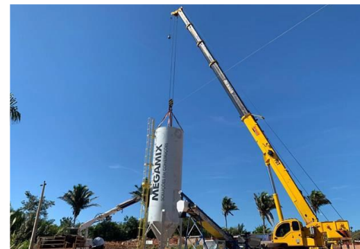
Instalação da usina de concreto
