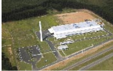
Unidade Filtros Mogi Guaçu
