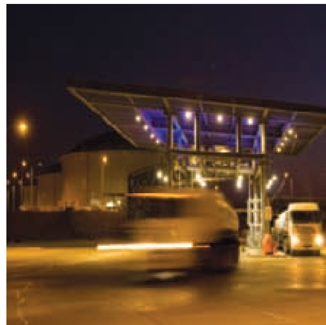
COPEC, PLANTA ALMACENAMIENTO MEJILLONES
