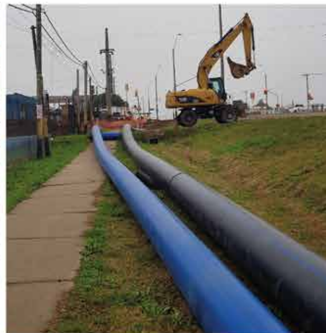
Canelones - Red de agua potable y vaina para cruce de Ruta mediante Instalación con tunelera - Año 2022
