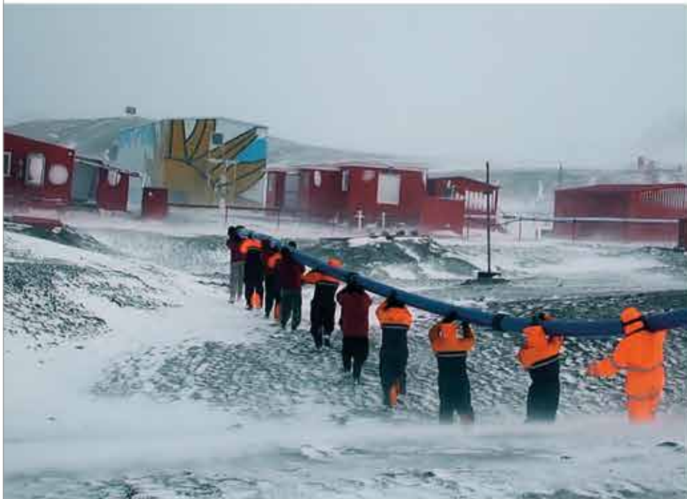
Base Científica General Artigas en la Antártida - Toma extractiva en la zona de deshielo del Lago Uruguay - Año 2019
