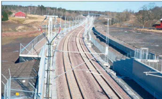
STOR SPENNING: Innen 2024 skal Vestfoldbanen være en moderne togstrekning med to spor og moderne stasjoner. Spenningen er stor om hvor traseen skal gå gjennom Horten kommune.
