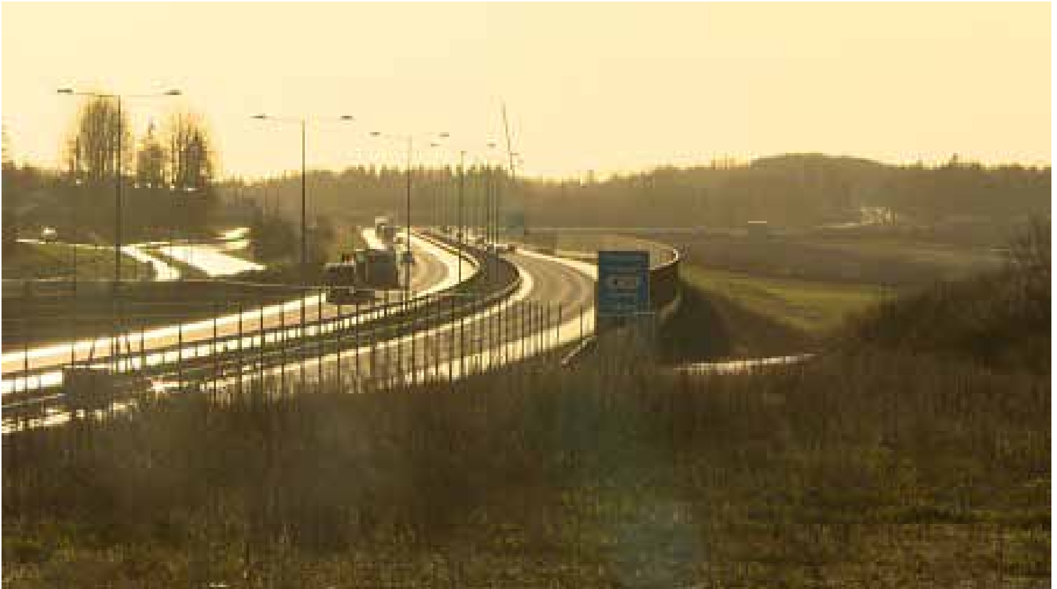
MATJORD TIL VEI: Deler av matjorda blir brukt til veibygging, som her på E18.
