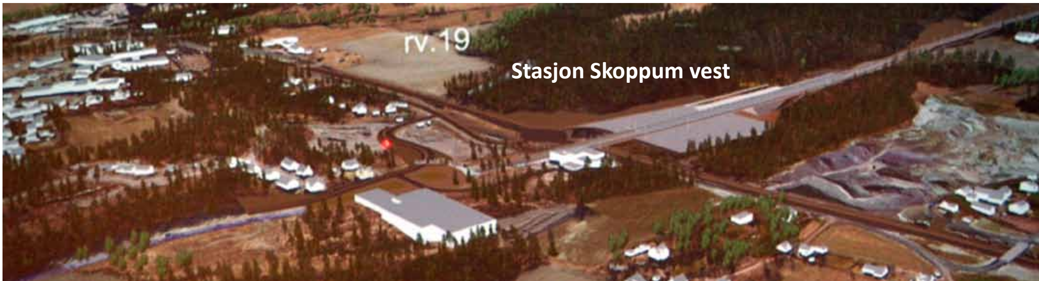
Monteringen over av bilde 1 og 2 er utført av KHV
