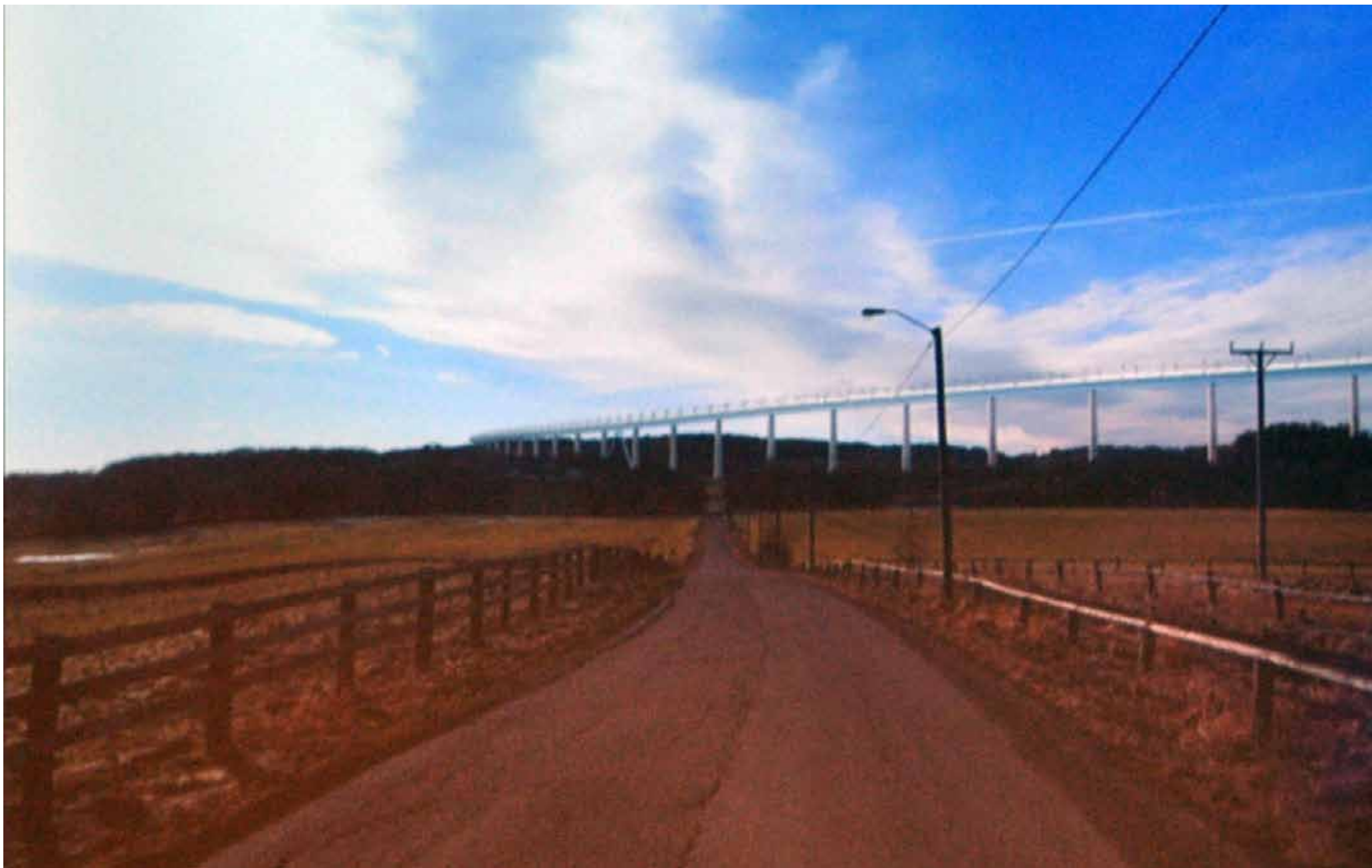
Viadukten mot Bakkenteigen sett fra Viksveien
