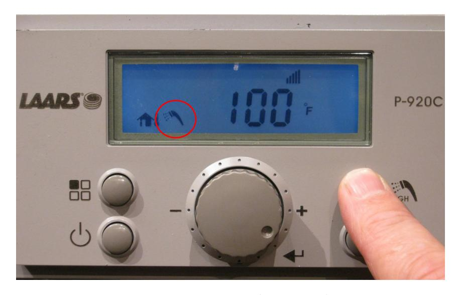
To set DHW set point Press DHW Button (combi boiler) You will see the DHW Icon
