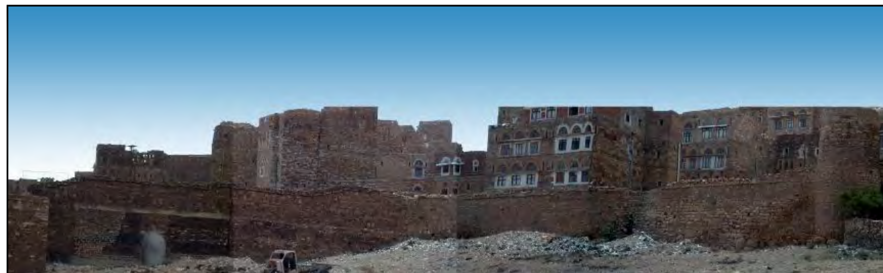
الواجهة الشمالية الشرقية لسور المدينة
