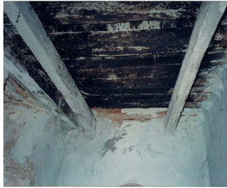
ETAT DE DEGRADATION DU PLANCHER
