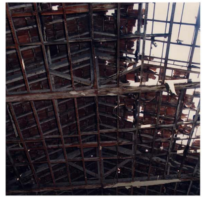
ETAT DE DELABREMENT DE LA CHARPENTE EN BOIS
