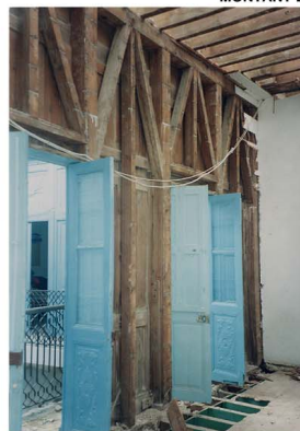
TRAVAUX DE RESTAURATION DE LA STRUCTURE PORTEUSE EN BOIS
