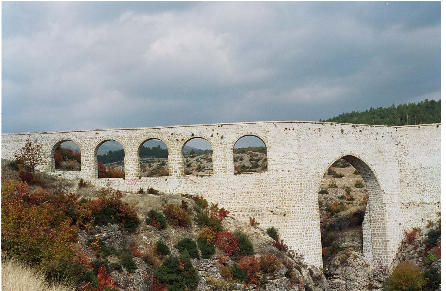
14-©ismet zühtü saraçoğlu İncekaya Aqueduct.JPG
