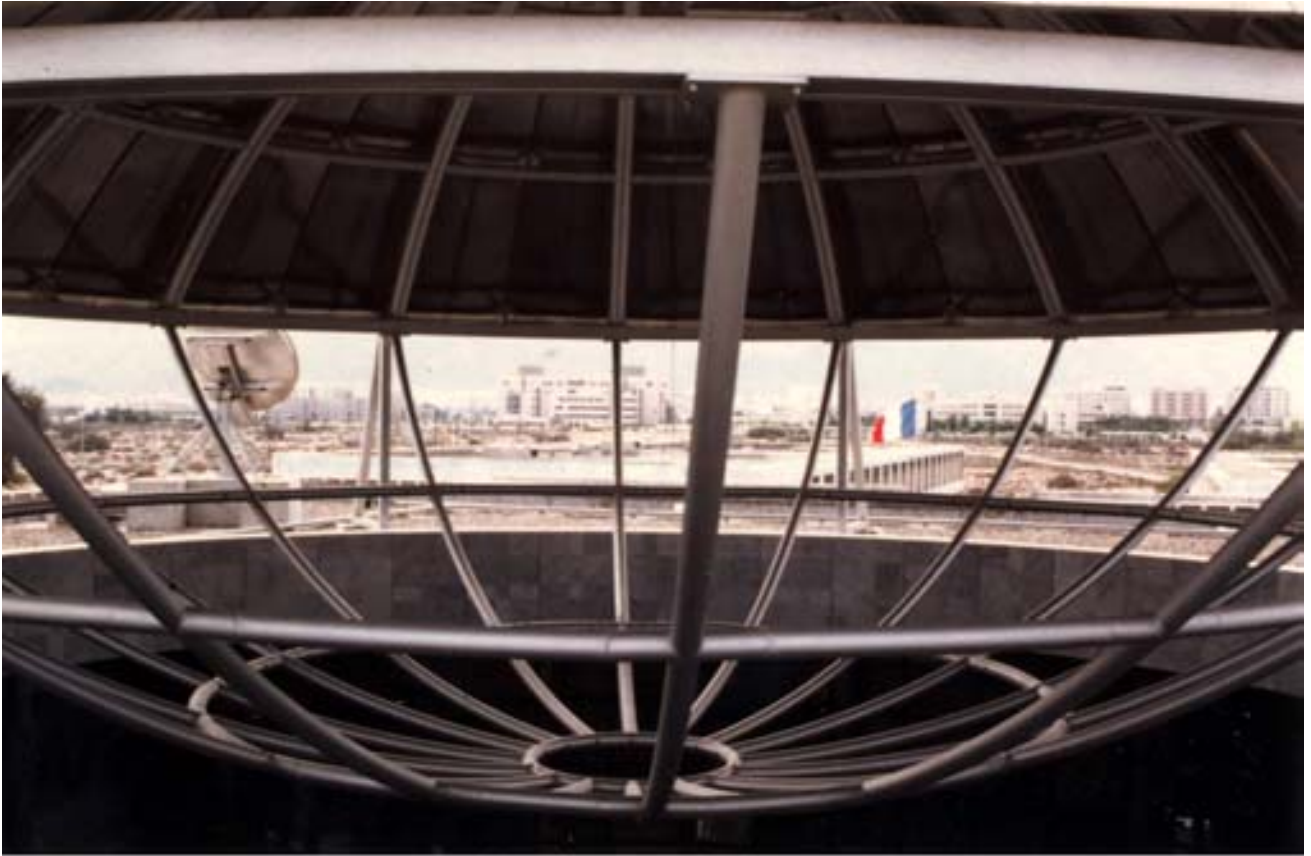
Vue à travers le dome
