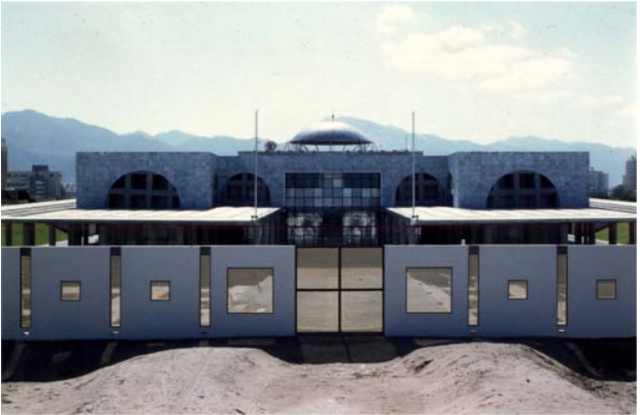
Façade nord vue depuis la mer
