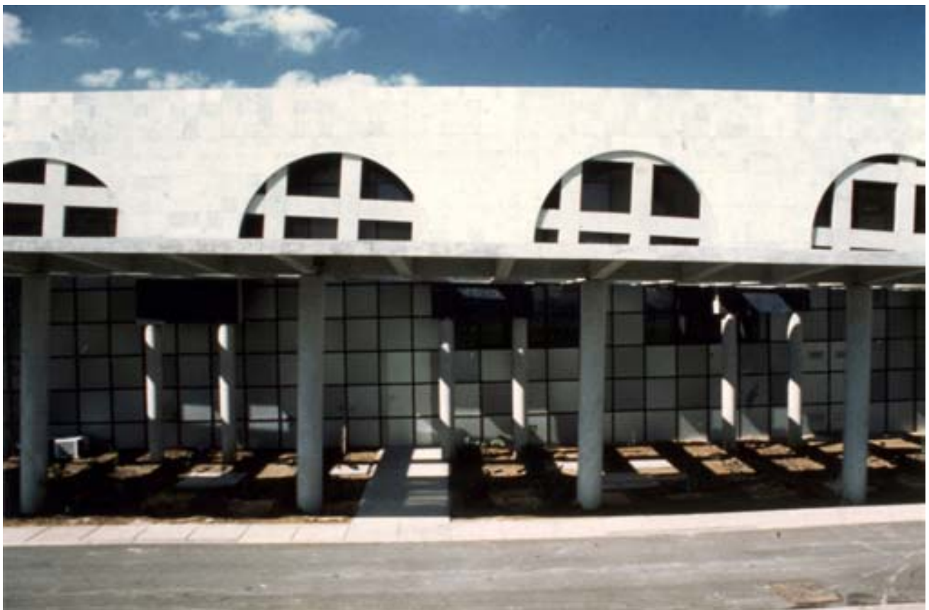
Détail de la façade Est
