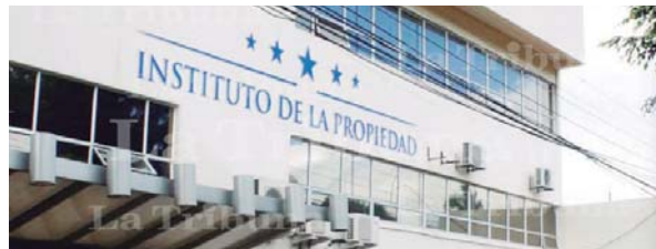
Esta semana, según las autoridades del IP, se continuará con los trabajos de reapertura de las oficinas a nivel nacional.
