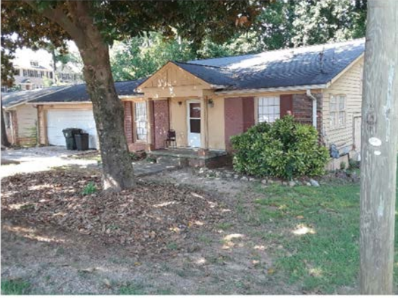
3723 Chamblee Dunwoody Rd
