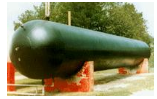
El mismo tanque de almacenamiento luego de una aplicación de Corroseal
