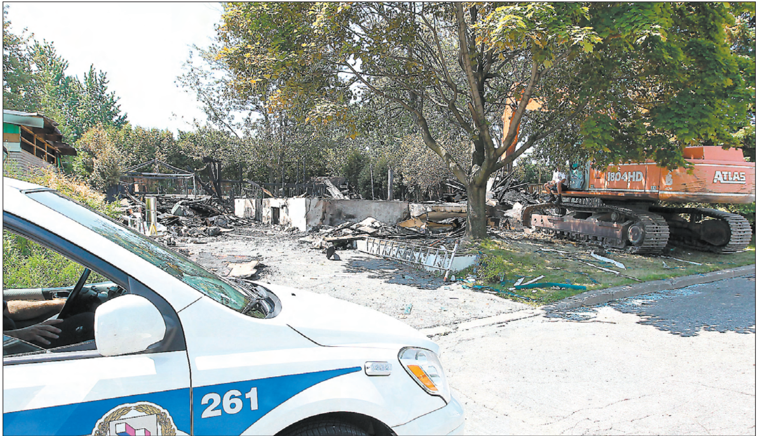
La maison de Pierre Jean Claude a complètement été détruite dans l'explosion.
