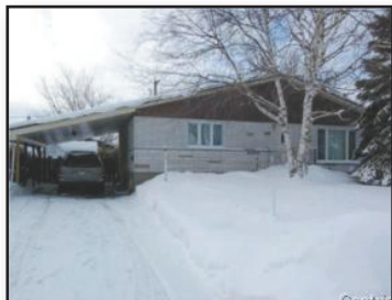
SAINT-EUSTACHE: Maison située près de l'autoroute 13 et d'une rue paisible. Idéal pour grande famille. Entrée indépendante sur le côté. Grande cuisine pour les repas familiaux. Terrain aménagé, clôturé avec piscine hors-terre, deck et cabanon. Hélène Racine et Mireille Pépin
