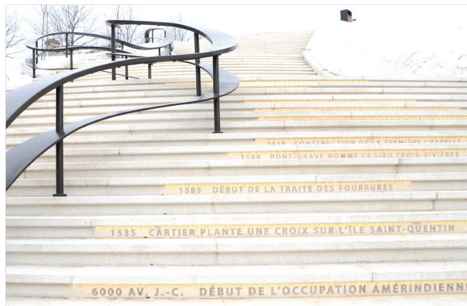
Une nouvelle rampe en acier inoxydable sera installée à droite sur l'escalier monumental. PHOTO GUILLAUME JACOB
