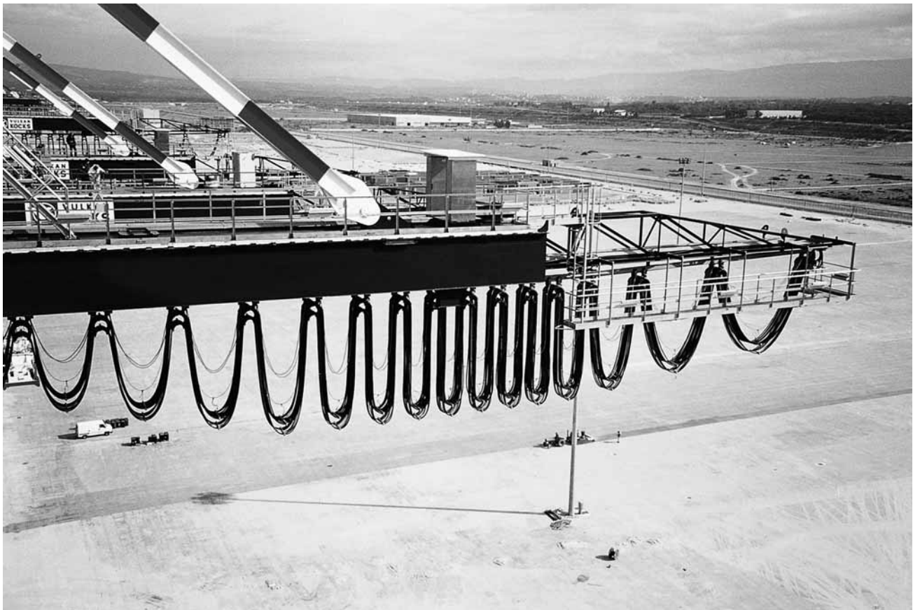
Instalación de Carros portacables para Grúa de contenedores
