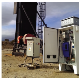
Bombeo de Petróleo Aplicación en Argentina
