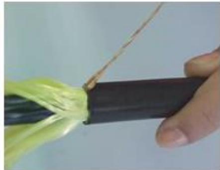
Corte longitudinal cubierta exterior
