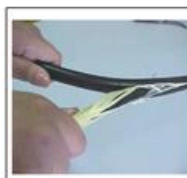
Despojo de cubierta exterior
