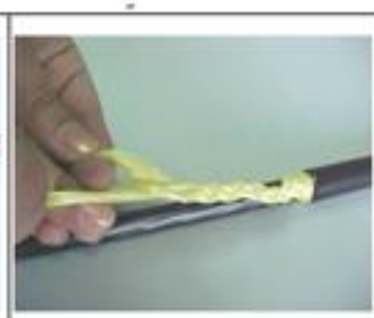
Trenzado de kevlar para posterior anclaje
