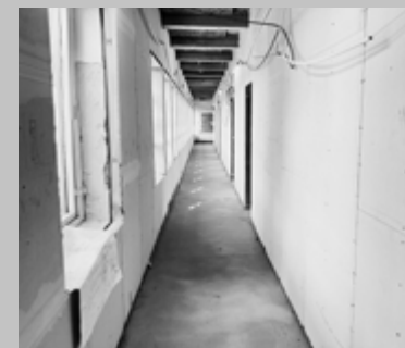
Stemmingsbillede fra byggeplads, januar 2020.
