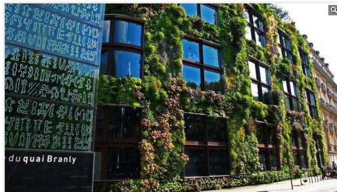
MAILAND, FRANKFURT, SINGAPUR So grün kann Architektur sein Paris (Frankreich) hat unzählige Museen – das Musée du Quai Branly ist das grünste. Patrick Blanc verwandelte die gesamte Frontseite des Musée du Quai Branly in einen vertikalen Garten Foto: Patrick Blanc, Architect Jean Nouvel 1 / 17
